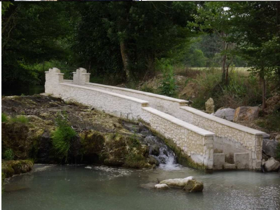
Vue définitive. L'ouvrage est terminé.
