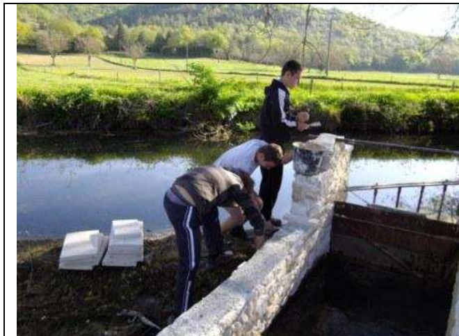
b) 19 avril 2011 : Jointoiment de la fausse pierre (Joint ton pierre)
