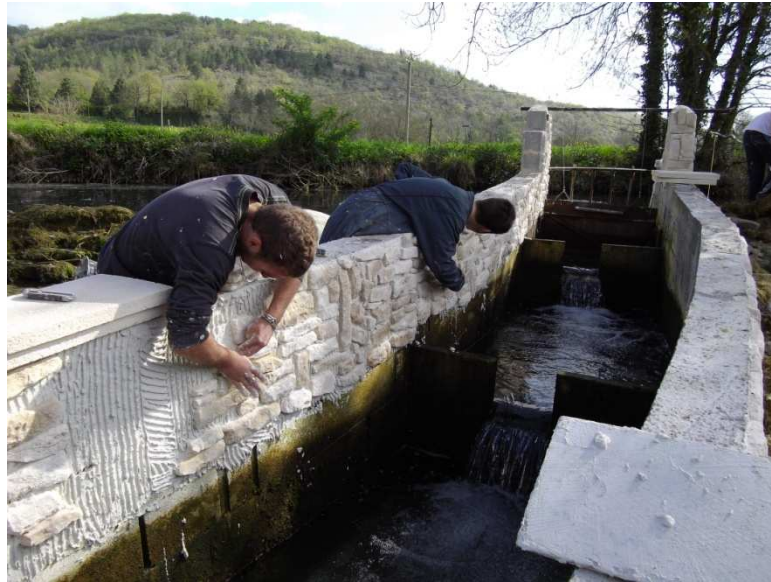
b) 19 avril 2011 : Jointoiment de la fausse pierre (Joint ton pierre)
