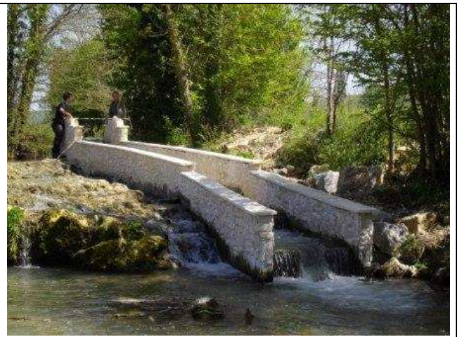
b) 19 avril 2011 : Jointoiment de la fausse pierre (Joint ton pierre)
